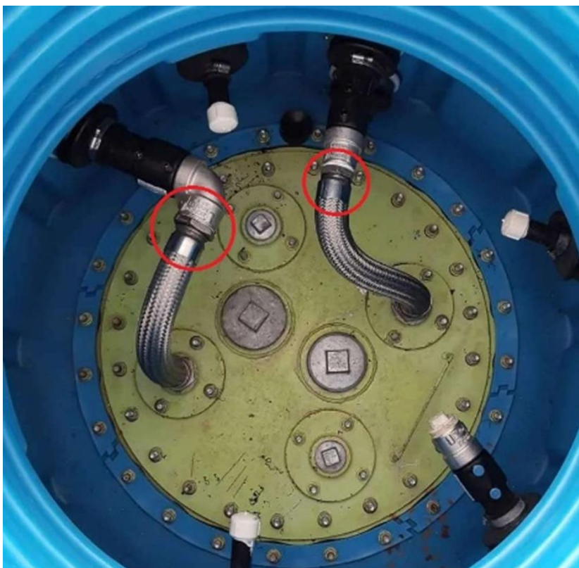
Figura 8 - Locais de instalação na saída de tanques.
