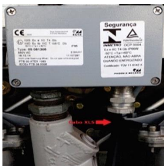
Figura 10 - Uso de prensa cabos Ex
